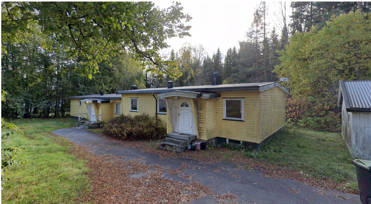
Glittreveien 21 A-B. Bildet er tatt okt. 2023. Kilde: Google Maps.
