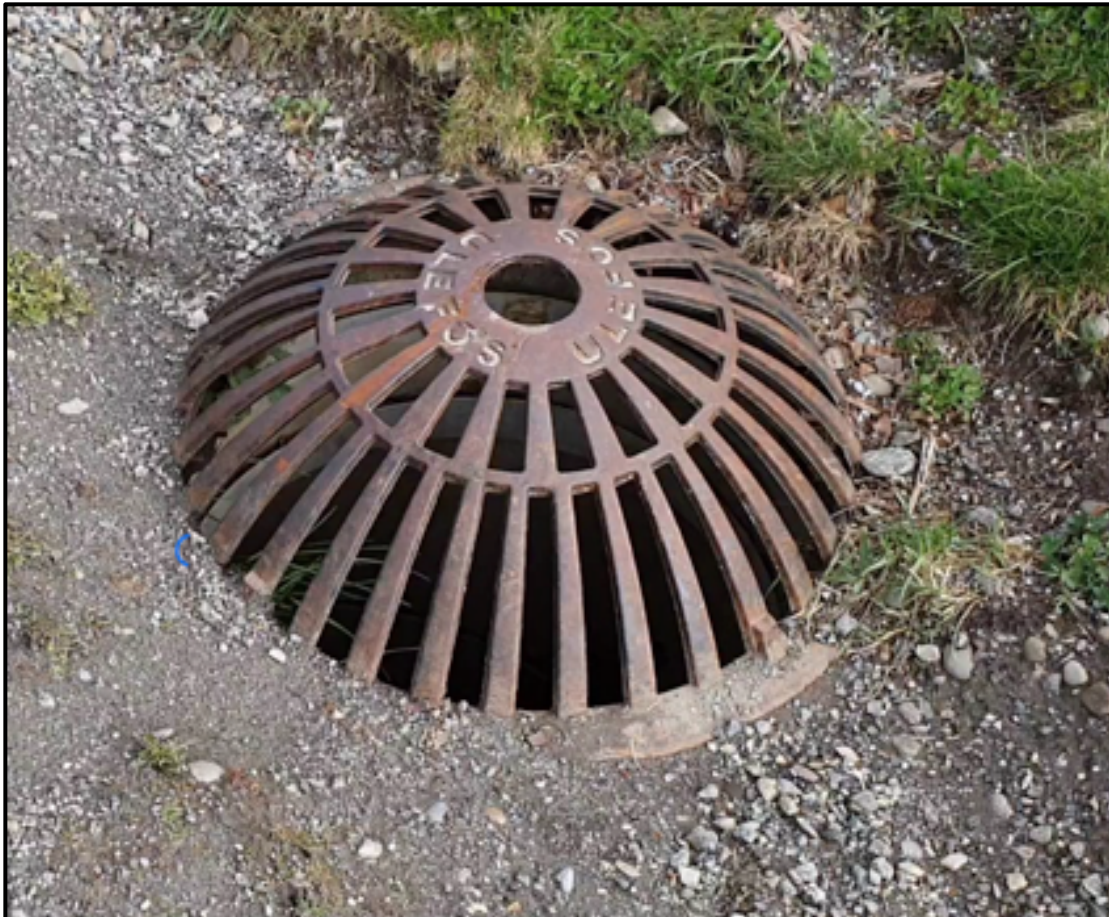
Figur 9. Sandfangskum som fungerer som dødsfelle for amfibier og småpattedyr.
