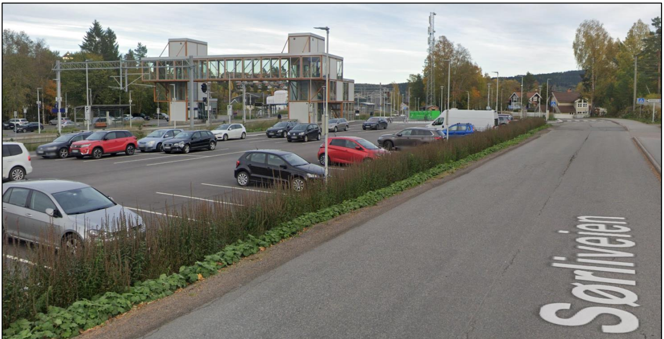
Figur 5 Ny gangbro ved Nittedal stasjon sett fra Søriveien på sørsiden av stasjonen (kilde: google streetview oktober 2023).
