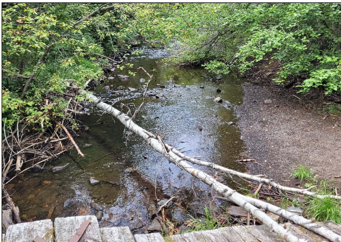
Figur 23. Ved prøvepunkt «SP3 - Ved bro» er det mye avsatt sand og grus langs østlige elvebanke. Trolig som følge av delvis brukollaps som sakker vannhastigheten og gir gode forhold for sedimentasjon. Bildet er tatt mot nordlig retning (oppstrøms).
