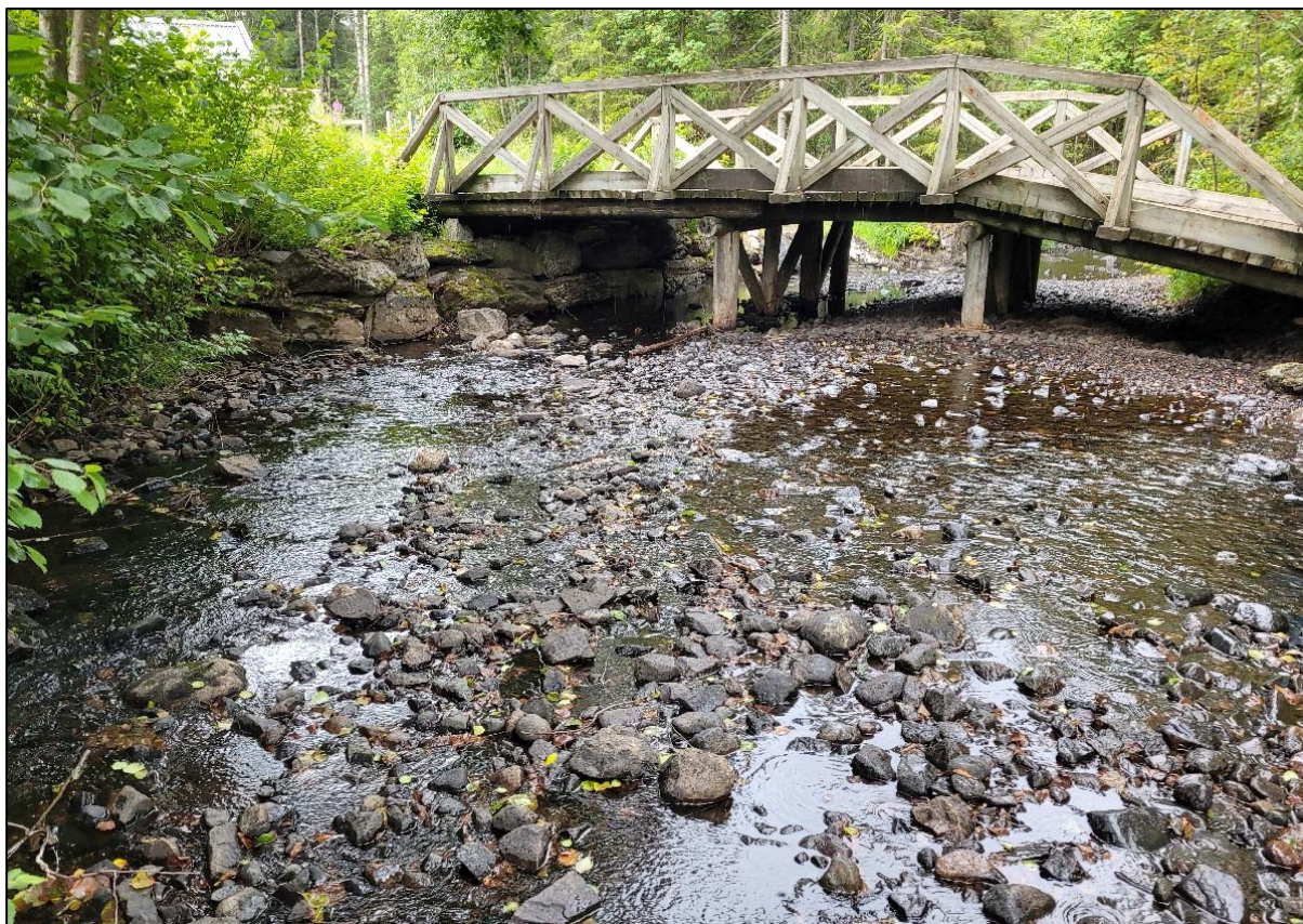
Figur 25. Prøvepunkt «SP5 – Oppstrøms» består av mye stein/blokk, men med noe mer grus og sand enn ved SP4. Bildet er tatt mot sørlig retning (nedstrøms).
