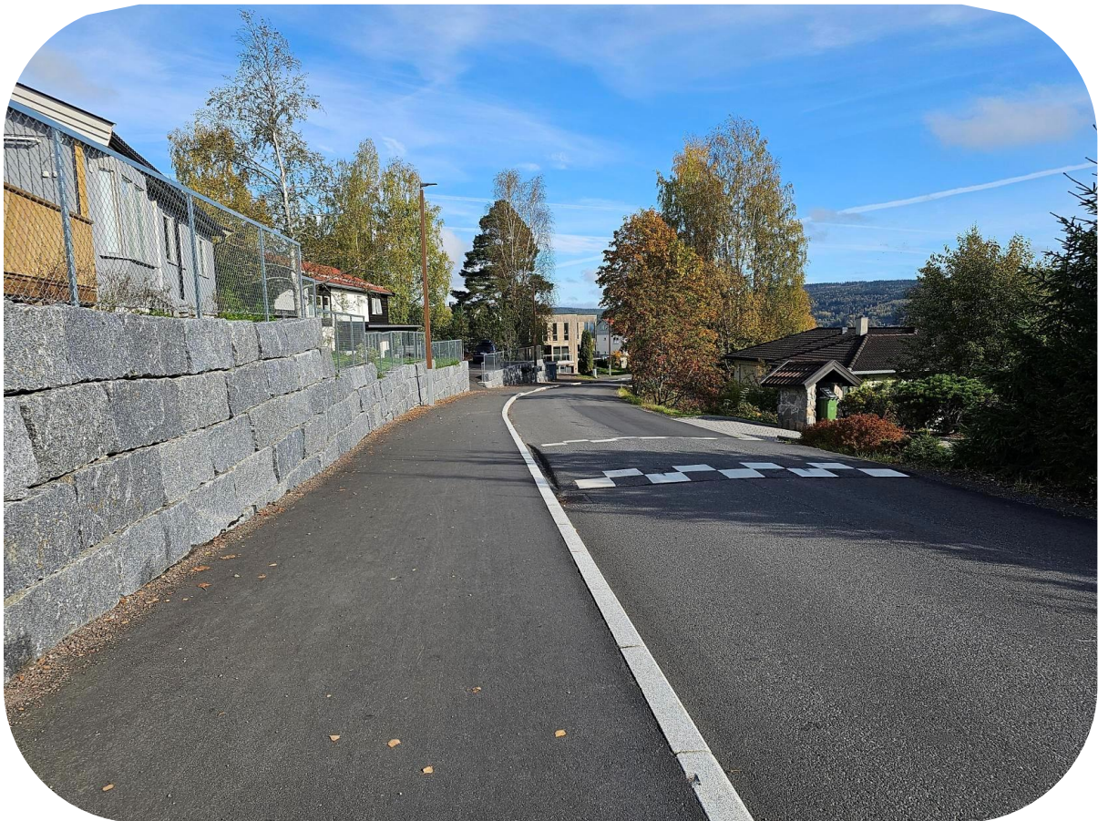
Bilde 18 - Sektoren har ansvar for å planlegge og bygge trafikksikkerhetstiltak. Her nytt fortau i Sagerudveien som sto ferdig i 2023.
