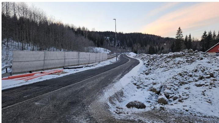
Gang-/sykkelvei langs Svartkruttveien åpnet på slutten av året. Bilde fra november 2023.
